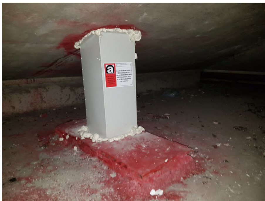
Figura 3 - Confinamento di una porzione di colonna di scarico
