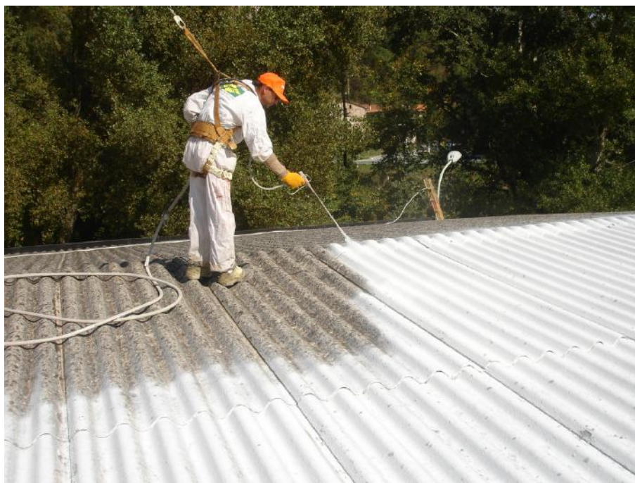
Figura 2 - Applicazione della soluzione incapsulante al materiale contenente amianto
