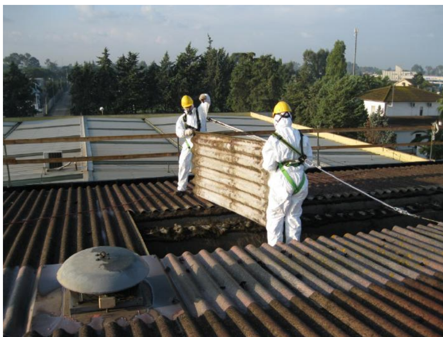
Figura 1 - Rimozione delle lastre di copertura in cemento-amianto
